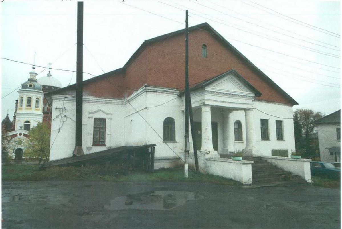
Фото 5. «Воскресенская церковь», Кировская область, г. Уржум, ул. Советская, д. 19. Фото Брызгалов Ю.П. Дата – 02.10.2014.
