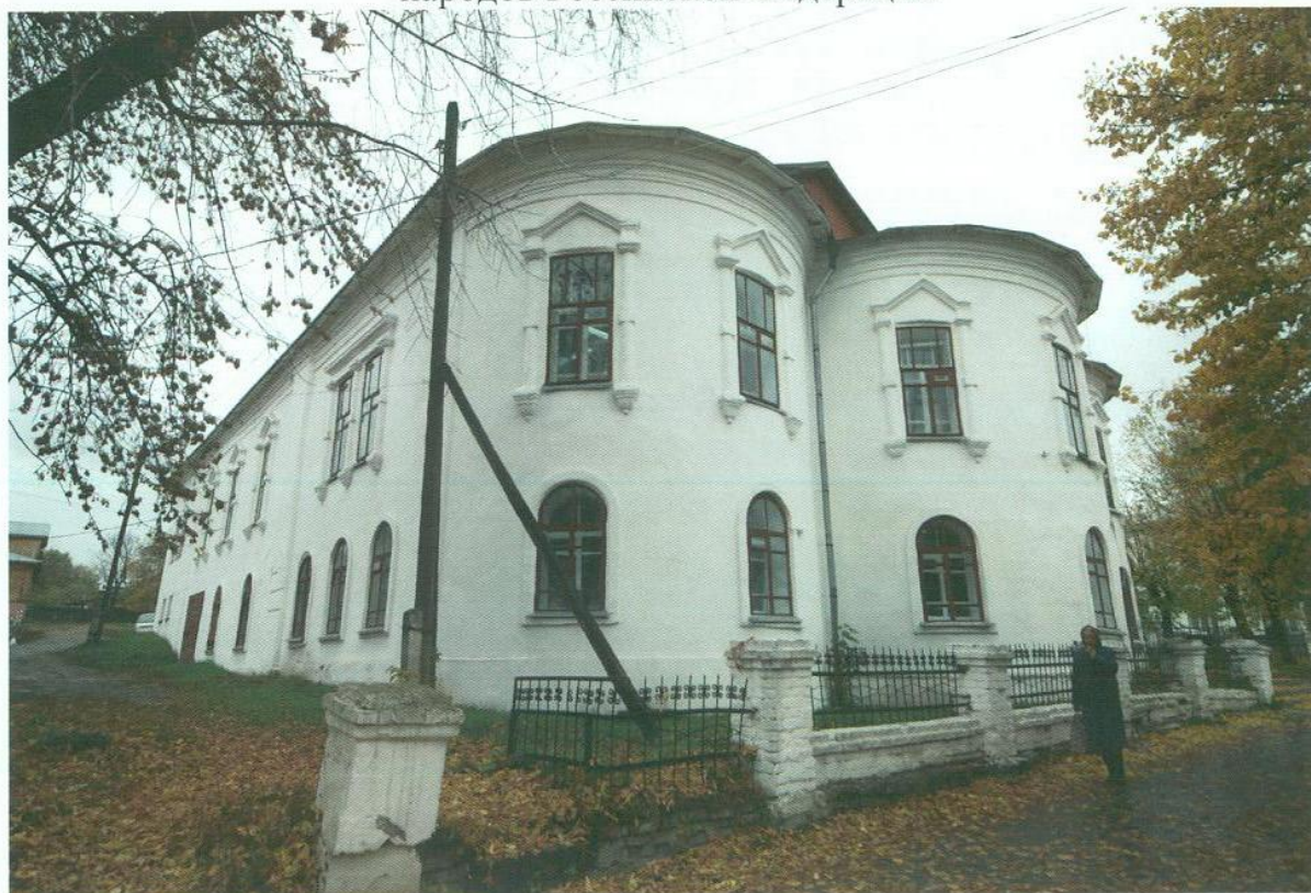
Фото 1. «Воскресенская церковь», Кировская область, г. Уржум, ул. Советская, д. 19. Фото Брызгалов Ю.П. Дата – 02.10.2014.
