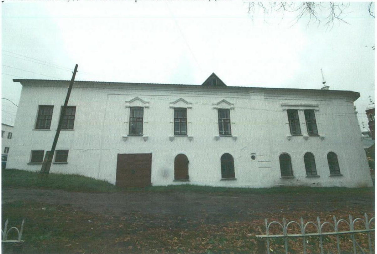
Фото 3. «Воскресенская церковь», Кировская область, г. Уржум, ул. Советская, д. 19. Фото Брызгалов Ю.П. Дата – 02.10.2014.
