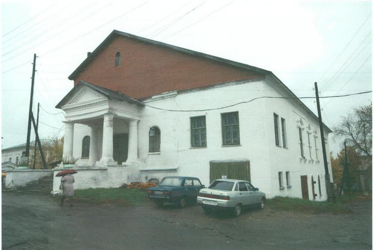
Фото 4. «Воскресенская церковь», Кировская область, г. Уржум, ул. Советская, д. 19. Фото Брызгалов Ю.П. Дата – 02.10.2014.
