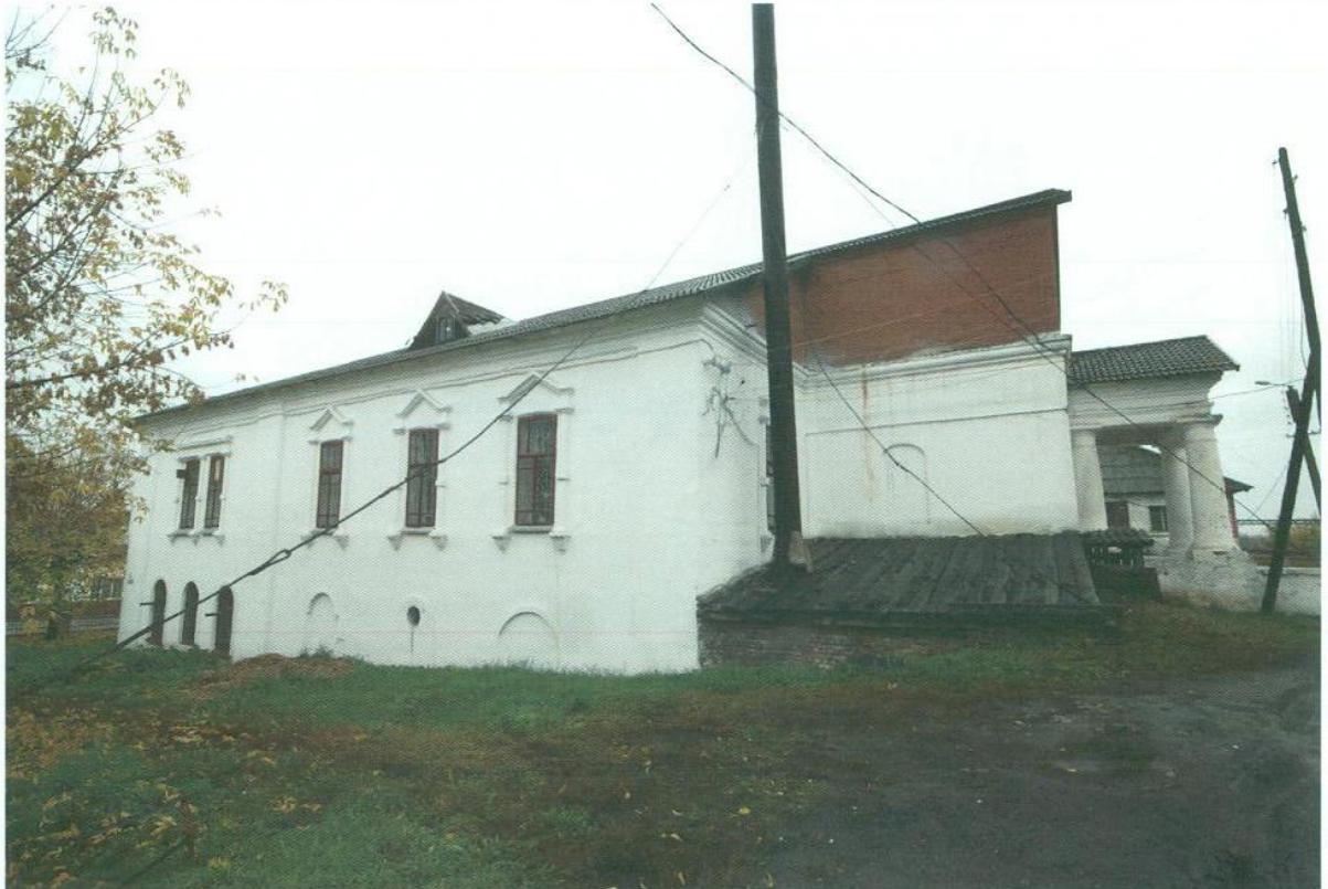
Фото 2. «Воскресенская церковь», Кировская область, г. Уржум, ул. Советская, д. 19. Фото Брызгалов Ю.П. Дата – 02.10.2014.
